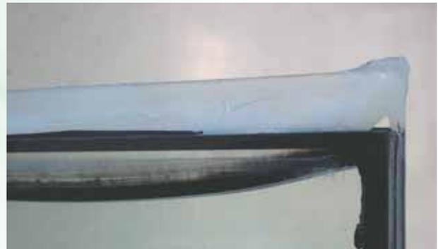
Bei der Ausführung von Traufpunktversiegelungen wird, wie auch in Abb. 3 zu sehen, neben der fehlerhaften Auswahl des Verglasungsdichtstoffes oft auch noch ein weiterer, gravierender Fehler gemacht. Hier wurde die Fugentiefe falsch dimensioniert, das heißt, sie wurde viel zu tief ausgelegt (siehe unten).
